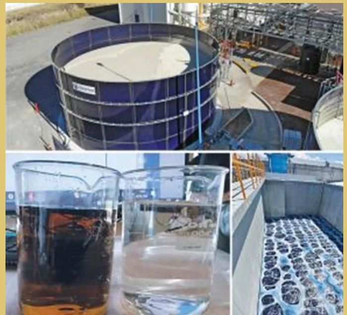
**Tanque de acero recubierto de fibra de vidrio para homogeneización de aguas residuales.**
