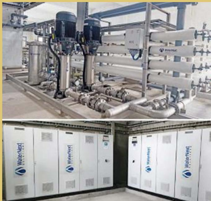
**Foto superior:** Sistema de Ósmosis Inversa para recuperación de agua tratada en procesos productivos textiles.
